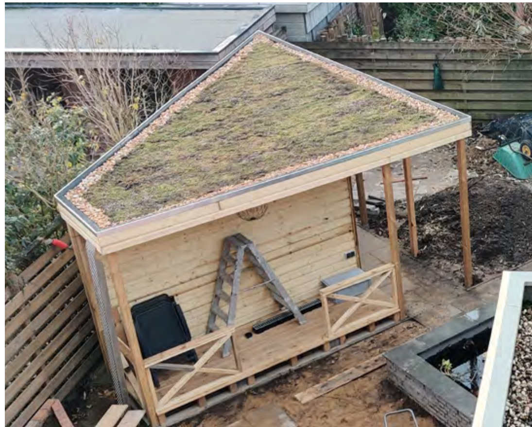
Een oppervlakte vanaf 5 vierkante meter is voldoende om een groen dak aan te leggen.
