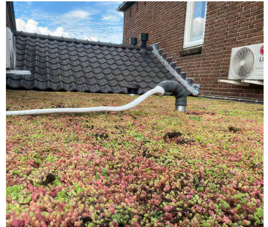
Groene daken hebben niet alleen waarde op het gebouw zelf, maar ook in de wijk eromheen.
