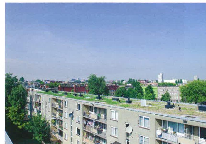
RESILIO: 12.683 m 2 blauw-groene daken op bestaande sociale huurwoningen en particulier vastgoed.
